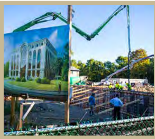
רייעס פון צענדליגער צעמענט טראקס מארשירן נאכאנאד פאר עטליכע שעה אריינצוגיסן די בעטאן אין די פארעמעס פאר די ווענט פון די פאנדעישאן
