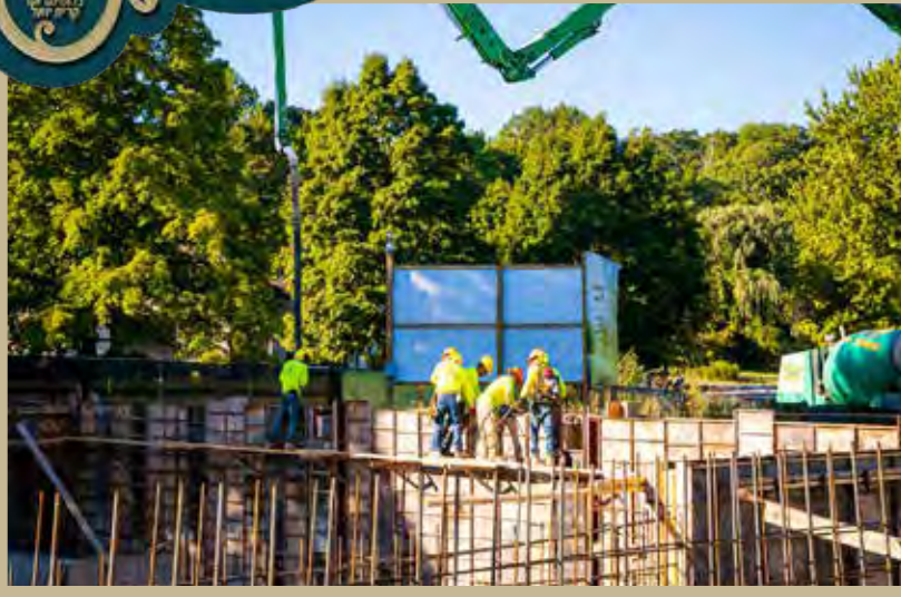
רייעס פון צענדליגער צעמענט טראקס מארשירן נאכאנאד פאר עטליכע שעה אריינצוגיסן די בעטאן אין די פארעמעס פאר די ווענט פון די פאנדעישאן
