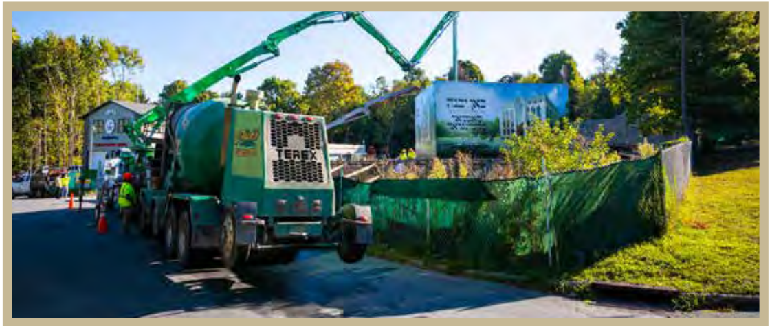
רייעס פון צענדליגער צעמענט טראקס מארשירן נאכאנאד פאר עטליכע שעה אריינצוגיסן די בעטאן אין די פארעמעס פאר די ווענט פון די פאנדעישאן
