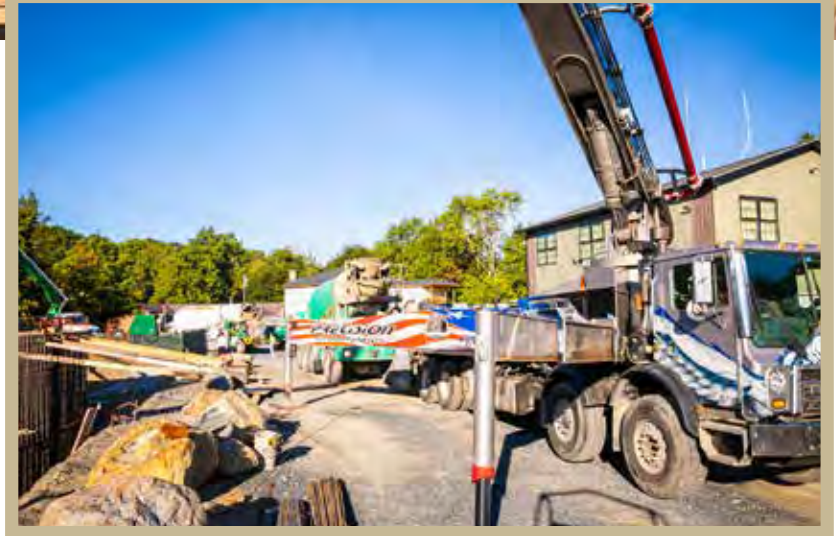
רייעס פון צענדליגער צעמענט טראקס מארשירן נאכאנאד פאר עטליכע שעה אריינצוגיסן די בעטאן אין די פארעמעס פאר די ווענט פון די פאנדעישאן
