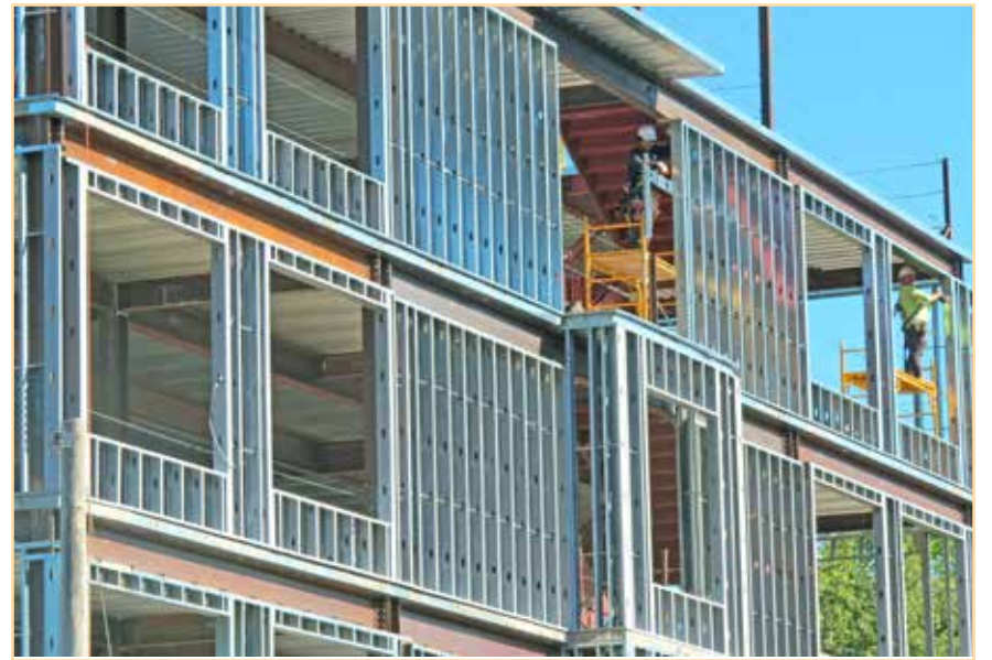
איזערנע סטודס פארענדיגט לענגאויס אלע שטאקן פון ביזנעס סענטער #7 אויפן רוט 208
