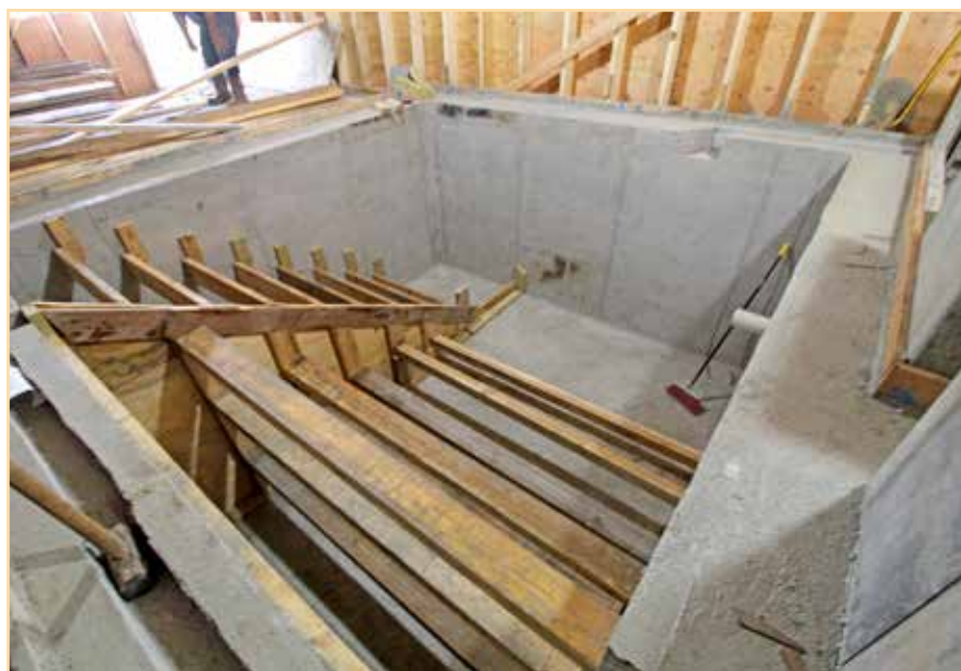
שטיגן ווערט פארענדיגט אינעם גרויסן בור הטבילה
