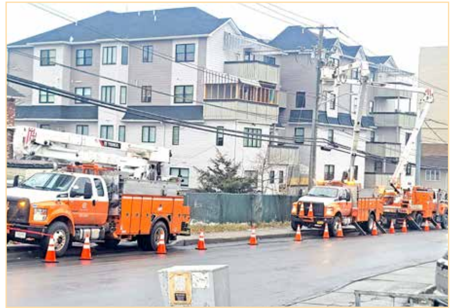
או. ענד אר. ארבעט אויף עלעקטריק ליניע איבערצוציען נייע ליינס אויף די געהעכערטע זוילן
