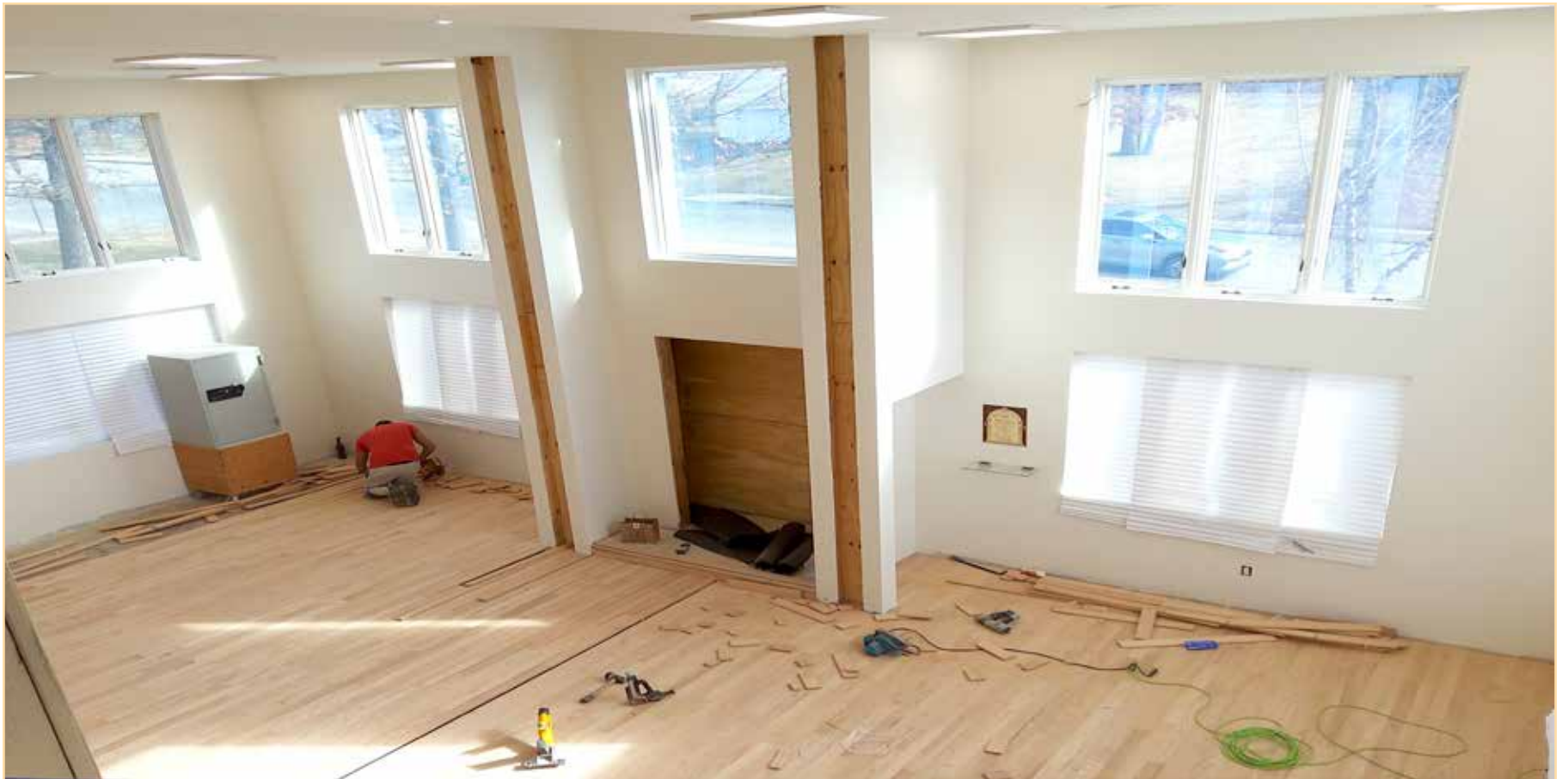
לעצטע ארבעט לגמור היכל המפואר מיט רצפת ההיכל פון שיינע פארקעי לשם ולתפארת
