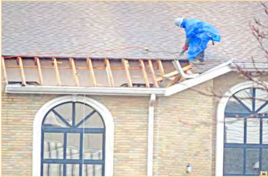
ארבעטער מיט עלעקטראנישע געצייג אוועקצושניידן אלטע דאך
