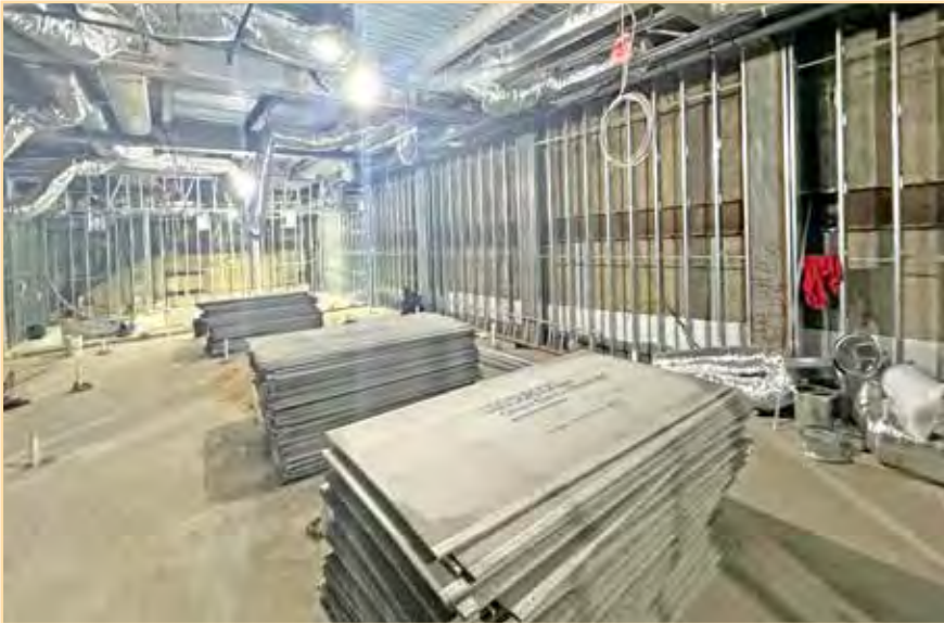
עיר קאנדישאן און יומידעפייער אינסטולאציע פארענדיגט אין חדר המקוה, ביי די בורות, און א באזונדערע סיסטעם העכער די שויערס
