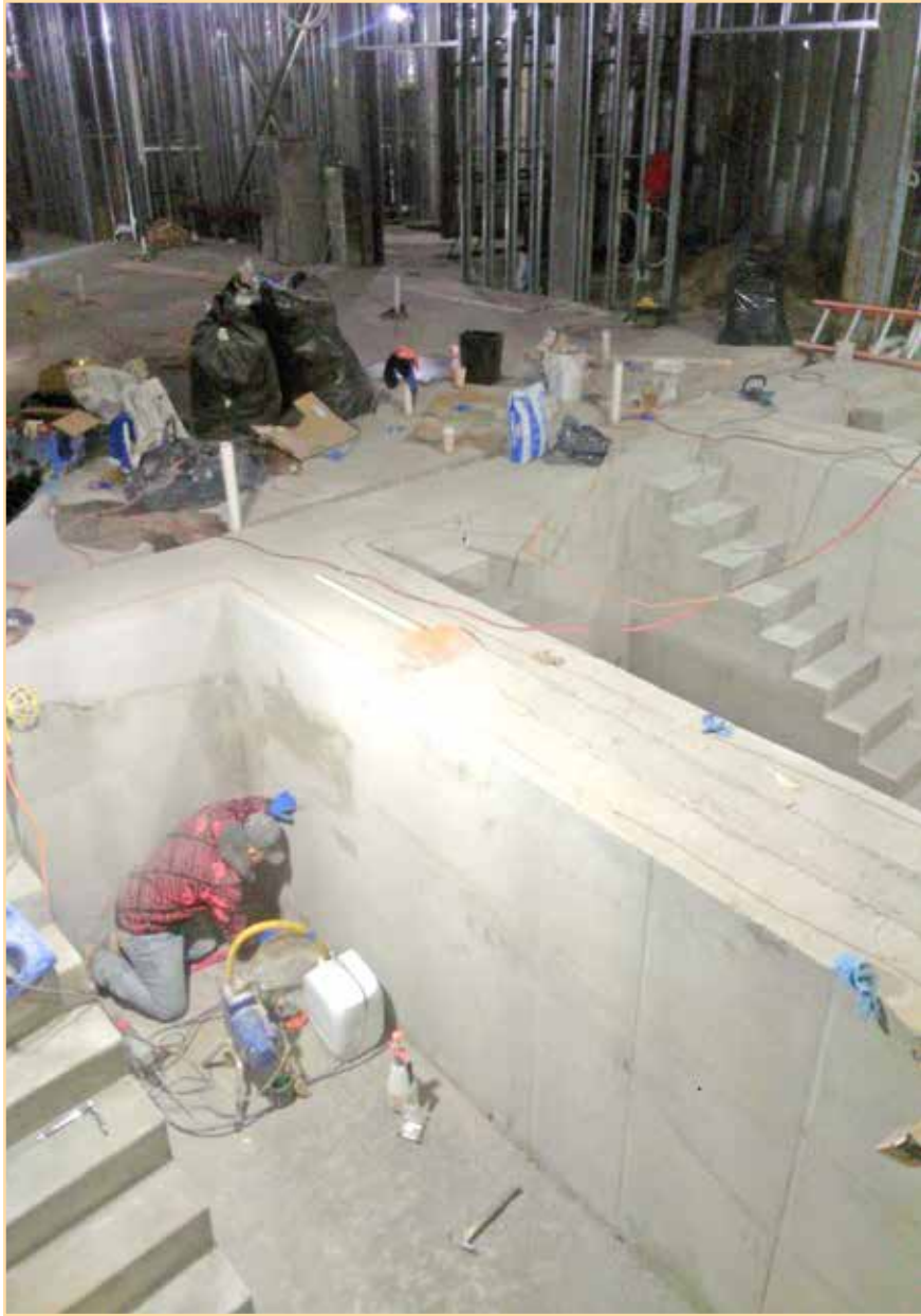
דעליקאטע ארבעט וואס האט זיך געצויגן עטליכע וואכן צו פארזיגלען די בורות הטבילה בעפארן צוטראגן צו די ווייטערדיגע בוי פאזעס
