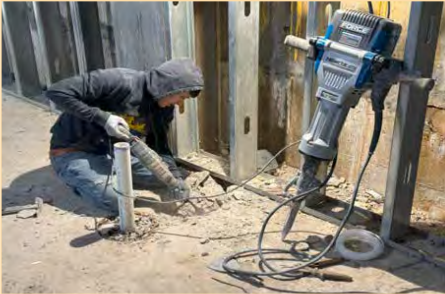
דעטאלירטע ארבעט נאך לאנגע חדשים מאניטערן די לעכער דורך אינסטאלירטע זיכערהייט קעמערס צווישן אלט און נייעם ביהמ"ד צו טרעפן די ליעקס און דאס פארזיגלען צו קענען פאראויסגיין אויפצובויען נייע מקוה
