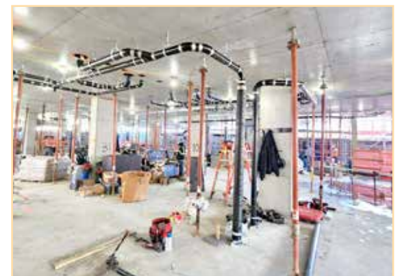
אין צייט וואס געביידע וואקסט אינדערהייער אין זעלטענע געלויף טוט די געביידע דזשומען מיט ארבעטער פון אינווייניג צו ציען פלאמביג, ספרינקלער סיסטעם א.א.וו.
