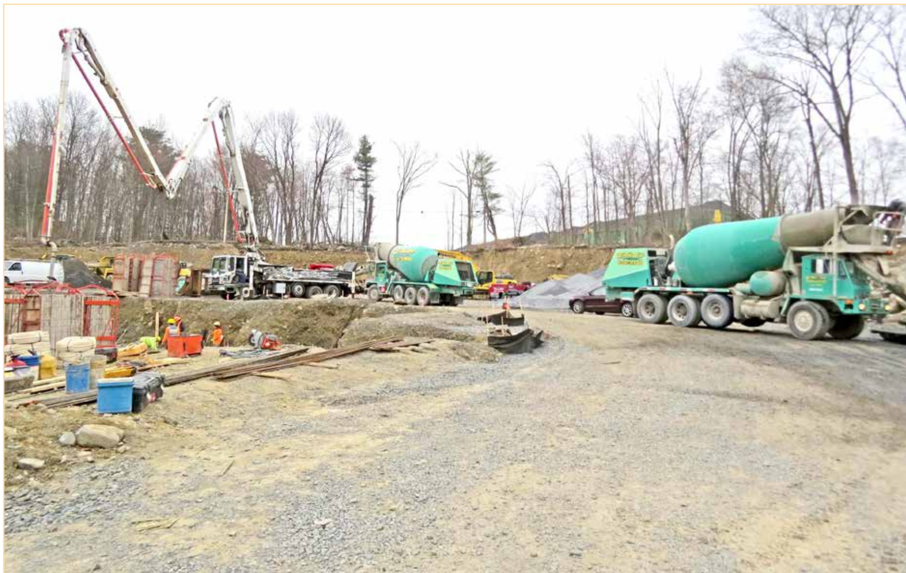
רייע צעמענט טראקס ביים פיטערן פאמפ טראק פארן ערשטן דירות געביידע אויף בעלזא - מערקט אין הונטערגרונט געביידע פון שכונת'דיגן שכונת ויואל משה
