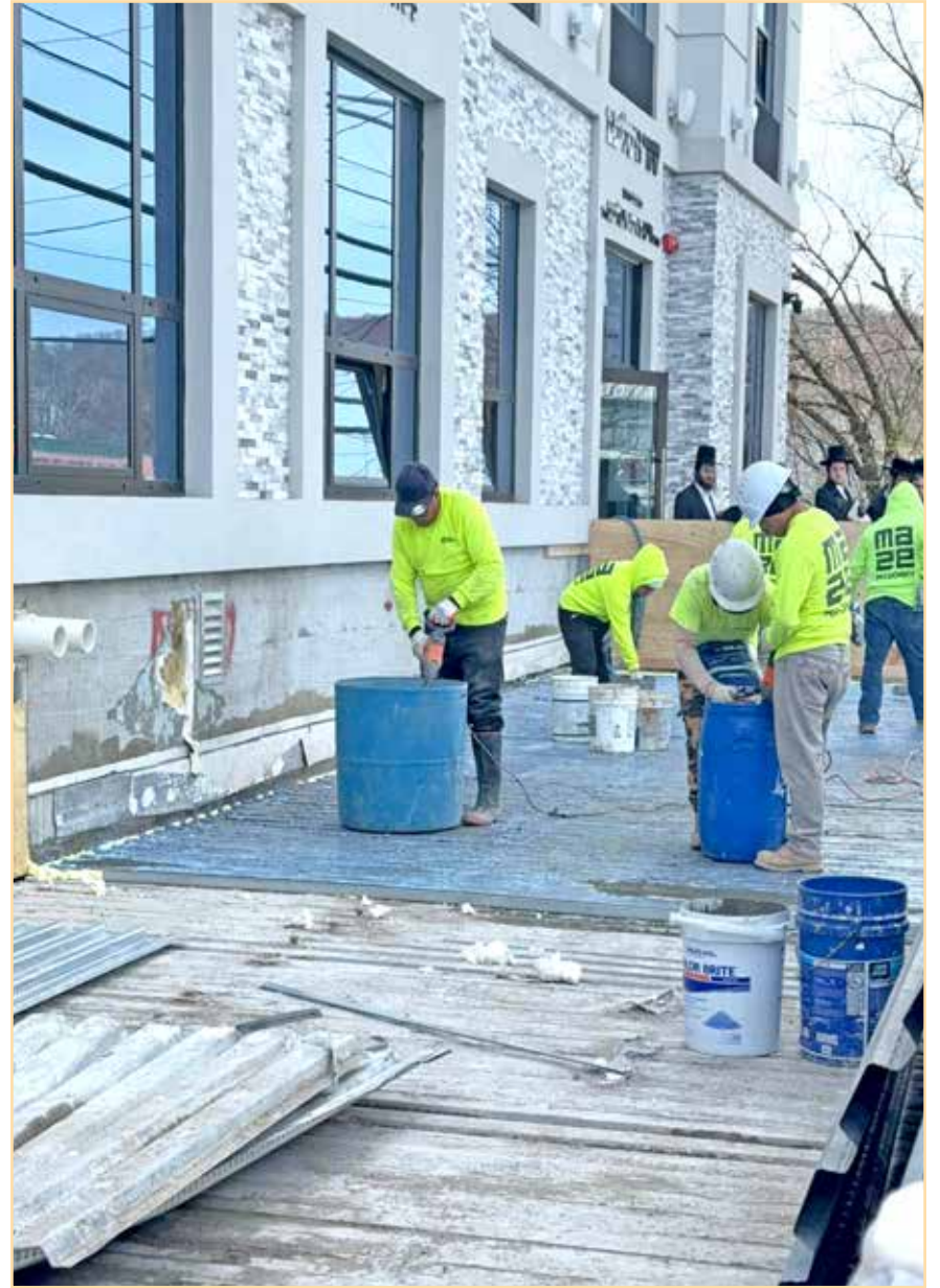
שטיינער פאדלאגע פון פארעסט באלקאן ערזעצט מיט דויערהאפטגיגע צעמענט צו סיעלן די מקוה שטאק
