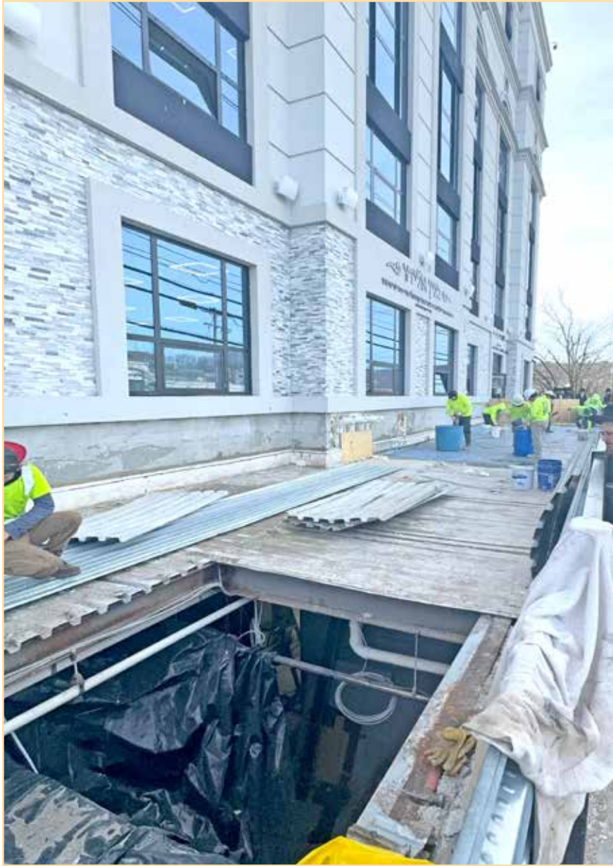
שטיינער פאדלאגע פון פארעסט באלקאן ערזעצט מיט דויערהאפטגיגע צעמענט צו סיעלן די מקוה שטאק
